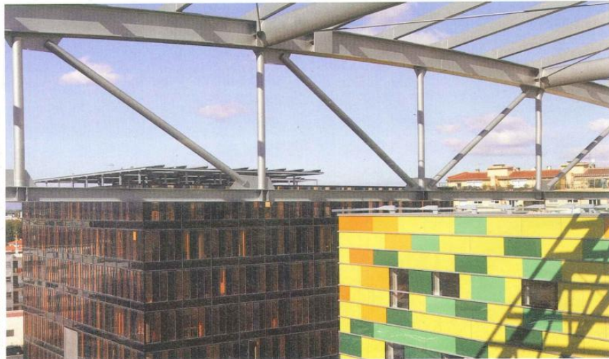
El Centre del Món de Jos Galán et l'Hôtel d'Agglomération réalisé par Dominique Perrault, l'architecte de la Bibliothèque Nationale de France.
