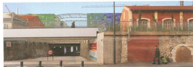
Quel contraste entre les 8 mètres de large du passage Dali et les 1,20 de l'ancien tunnel dont l'entrée (à droite) est à présent murée !
