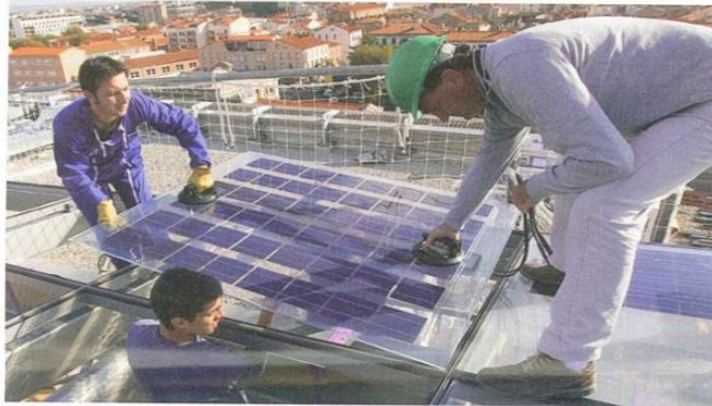
Perchés sur une plate-forme suspendue à la vague, les techniciens de l'entreprise perpignanaise Cansol posent les modules photovoltaïques.
